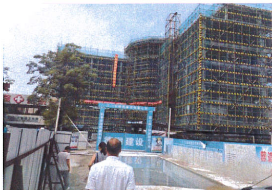
新会区住建局检查大鳌镇卫生院综合楼工程勘察设计 施工总承包项目
