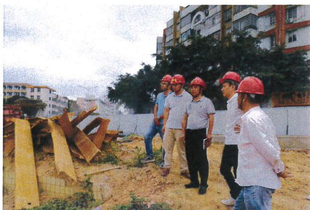
江门市住建局检查“西区工业桥及环市一路项目”
