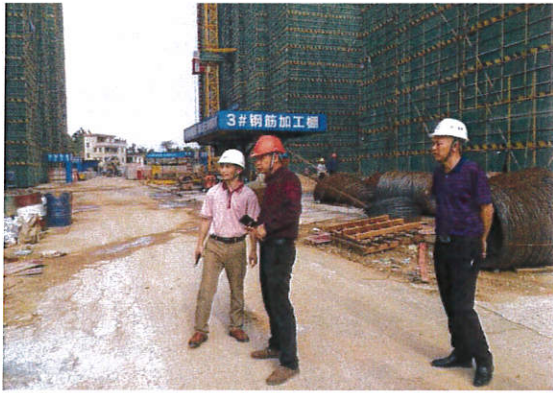
台山市住建局检查敏捷悦府项目
