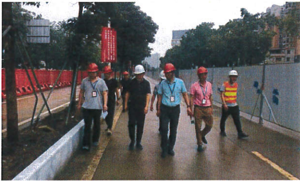
蓬江区住建局检查港口二路(迎宾路—江侨路) 道路沥青化改造及品质提升工程
