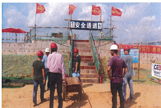
开平市住建局检查新一轮生活污水处理设施整市捆绑 PPP 项目
